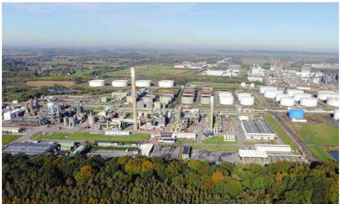
Les travaux de réhabilitation seront orchestrés par la SPAQuE. © SPAQUÉ
